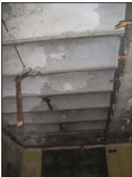
Coberta de bigues al sud del soterrani
