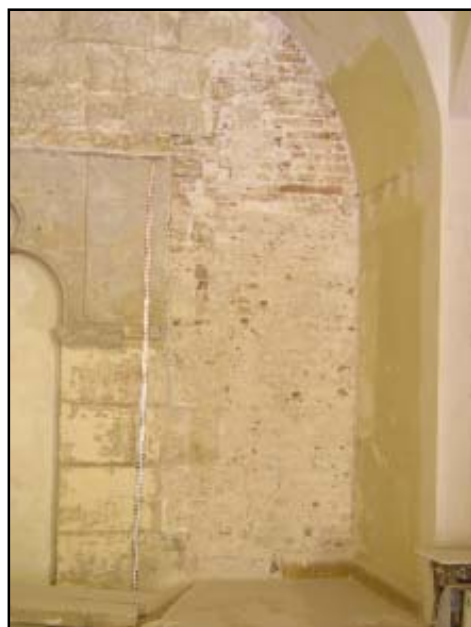
Trencament OB-42 al MR-2, amb la reparació MR-4
