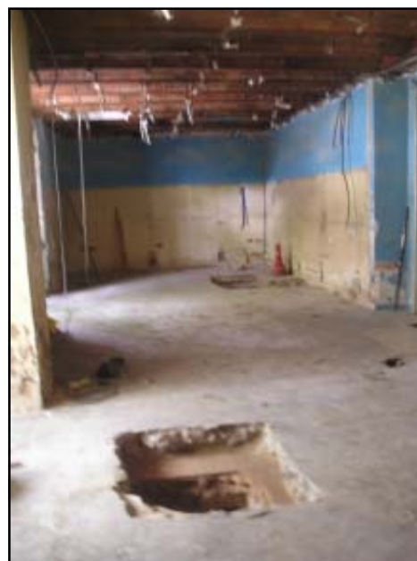
Vista general de la zona S des de l'est, amb el sondeig II a primer terme
