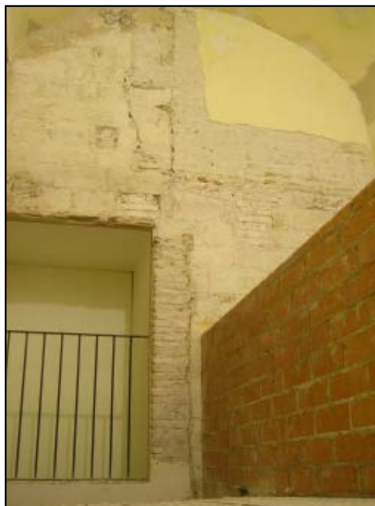
Trencaments OB-23 i 37
