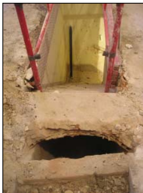
Escala d'accés al soterrani, amb les restes de maons associades amb la possible escala anterior
