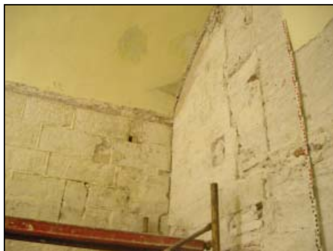
Extrem nord del MR-3, amb el contacte amb el MR-2. S'observa la seva relació estratigràfica de solidaritat entre els dos murs
