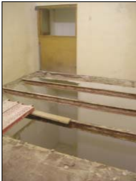
Procés de desmuntatge de la coberta de la planta baixa de l'àmbit 4
