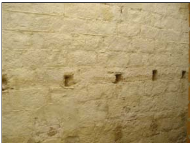
Trencaments OB-26 al MR-2
