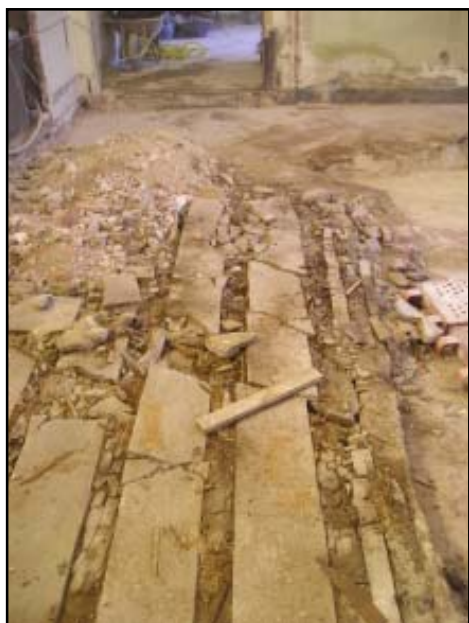
Retirada dels paviments i rebliments previs a la planta baixa
