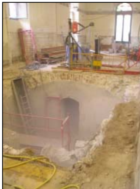
Perfil de la volta del soterrani, des de la zona desmuntada de l a mateixa
