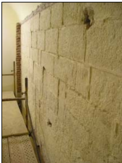
Detall del parament del MR-2, amb les restes de l'encintat de morter
