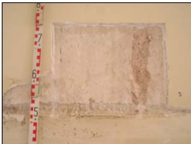
Revestiment de calç i sorra del mur, localitzat al sondeig 3
