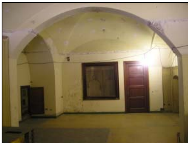
Zona nord de l'àmbit 5 a l'inici dels treballs
