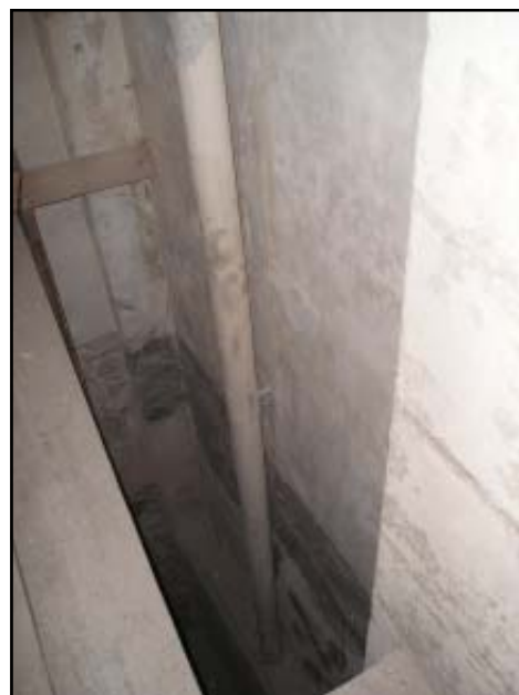
Mainell de pedra de l'OB-1
