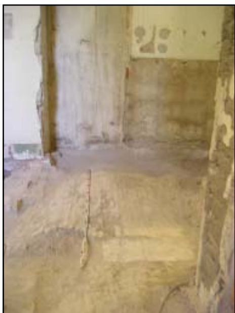
Part superior de la volta de coberta del soterrani
