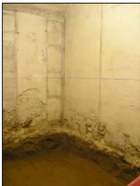
Detall dels murs de tancament del soterrani assentats al damunt de l'UE-1.034
