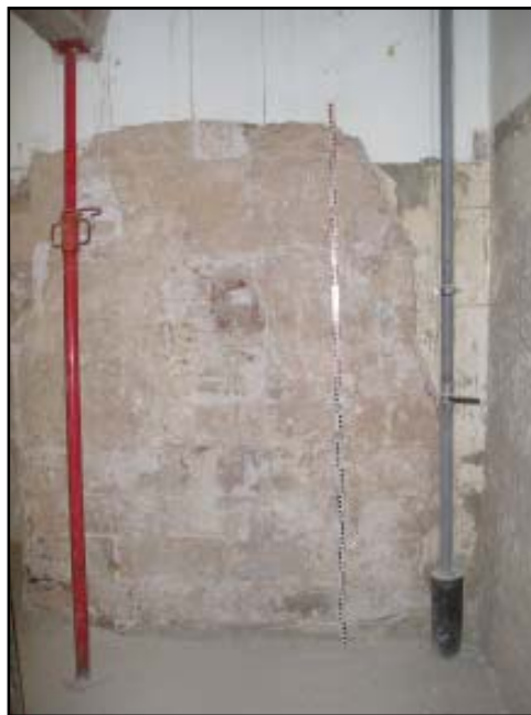
Extrem nord del MR-3 a la planta baixa, amb els trencaments OB-38 i 39
