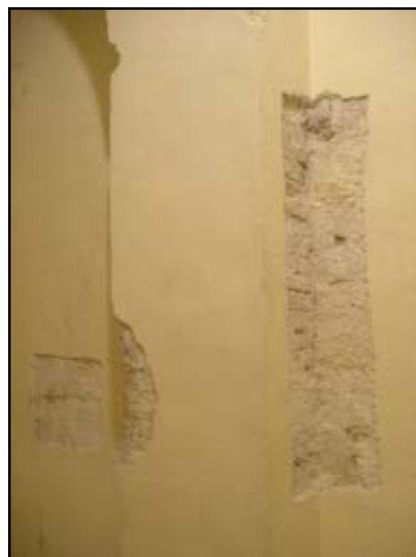
Zona de contacte de la base de l'arc de coberta amb el mur nord de l'àmbit 4
