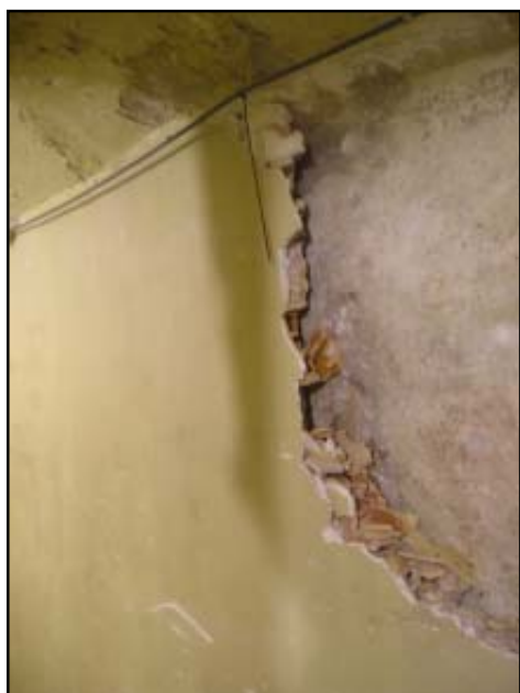
Detall dels envans de cobertura dels murs de tancament
