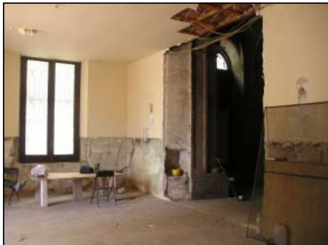
Extrem sud-est de la planta baixa de l'àmbit 3, amb el sondeig 1 al mur est
