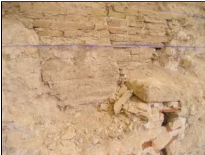
Obertura tapiada al sud del mur est del soterrani
