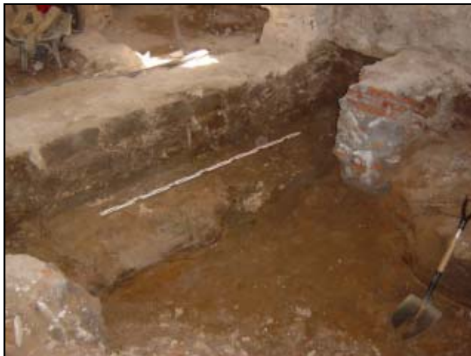
Part inferior del mur UE-1.018 i la seva fonamentació UE-1.014
