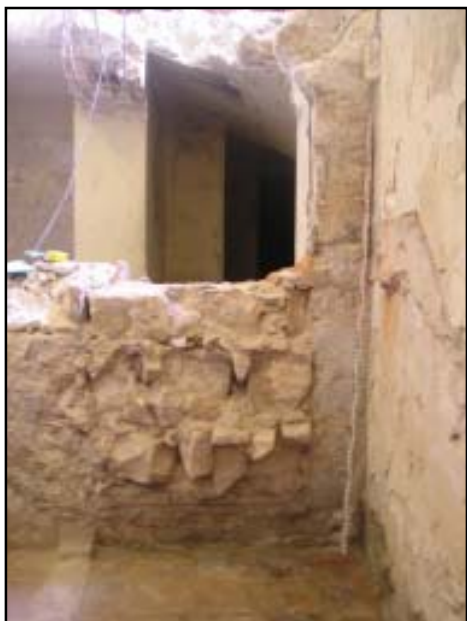
Obertura tapiada al mur UE-1.018
