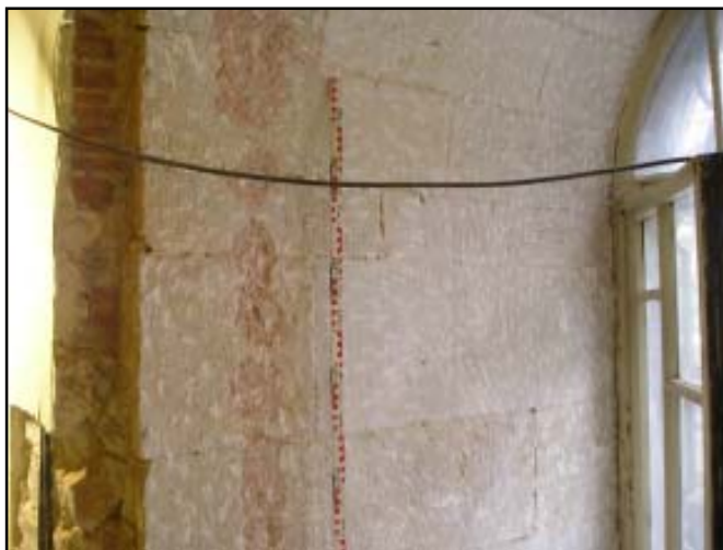
Detall de l'extrem est de l'OB-4, amb l'estructura de revestiment del segle XVIII, que se li lliura
