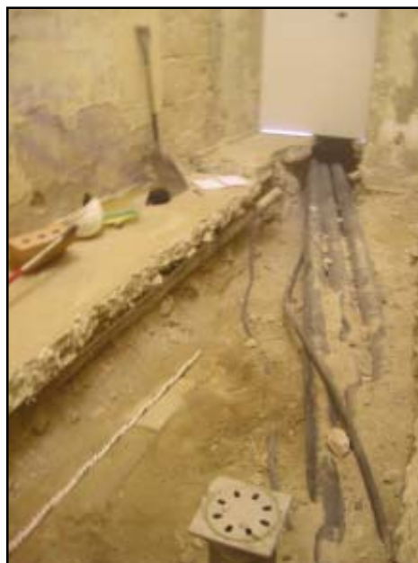
Rebaix a la planta baixa de l'àmbit 4, amb les restes del paviment localitzades
